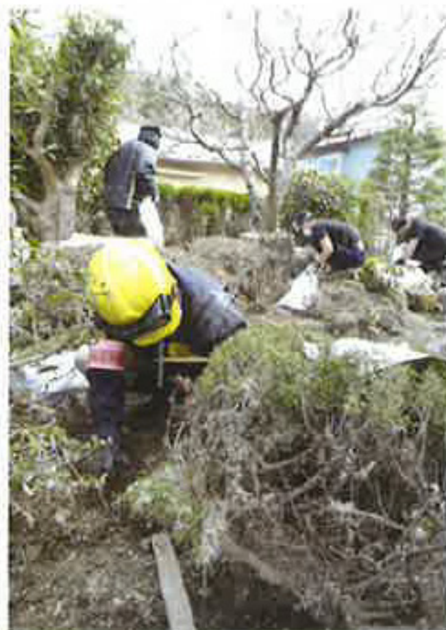
庭の汚泥を手でかき出します
